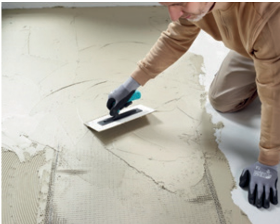
Abbildung 11: Weitere Lage Dichtbahnkleber auftragen (Hinweise zur Klebung der Dichtbahn des jeweiligen Dichtbahnherstellers beachten).
