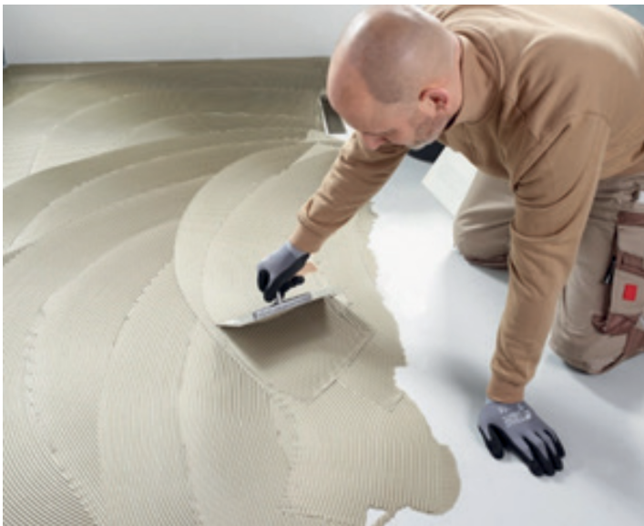
Abbildung 9: Fliesenkleber auftragen (6 mm Zahnung).
