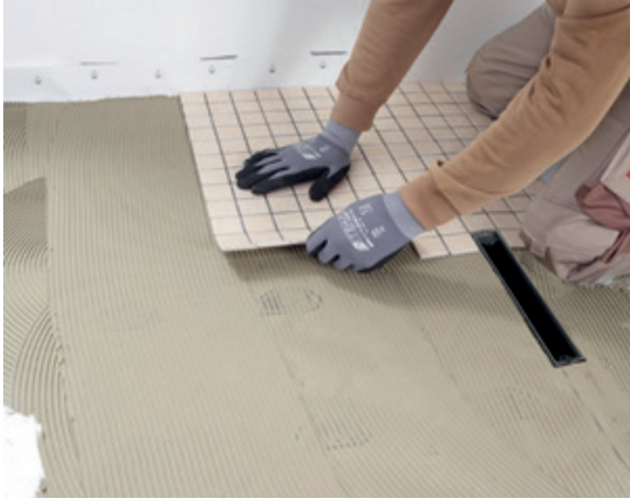
Abbildung 13: Fliesenkleber auftragen und Fliesen legen.
