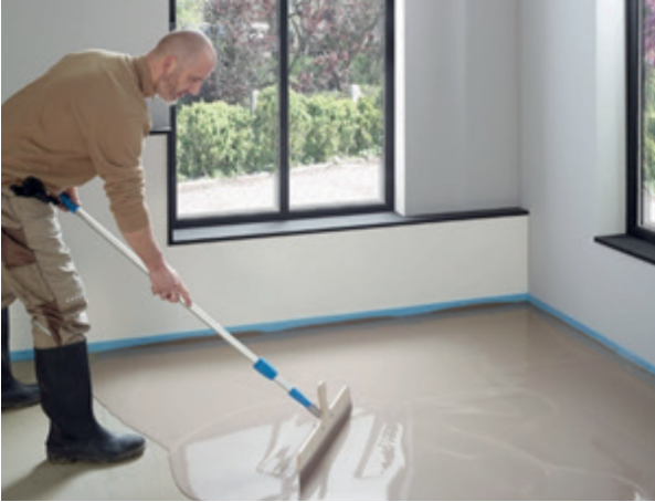
Abbildung 18: Dünn nivellieren und entlüften
