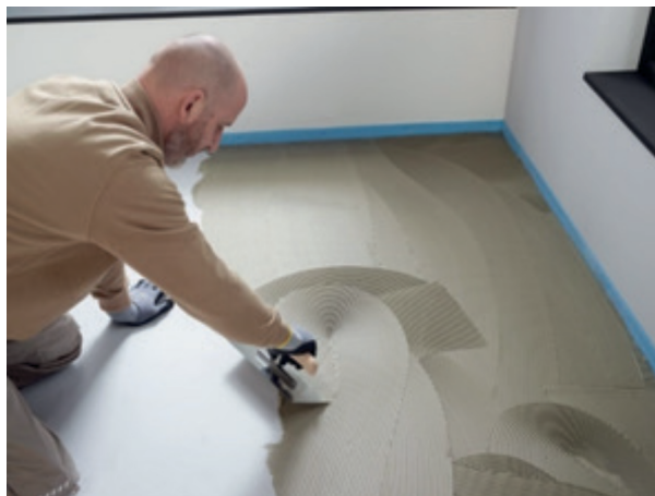
Abbildung 15: Kleber auftragen (4 - 6 mm Zahnung)
