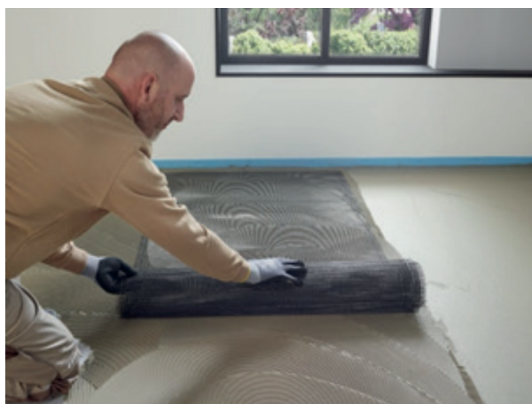
Abbildung 16: thermoheld •FLIESE• einlegen
