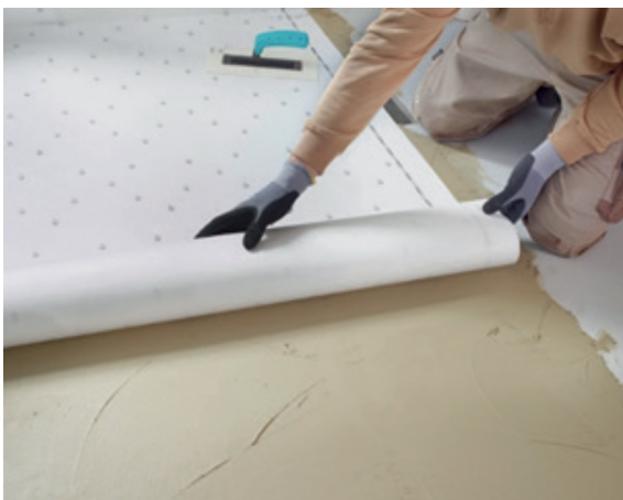
Abbildung 12: Dichtbahn direkt in den noch feuchten Dichtbahnkleber legen.
