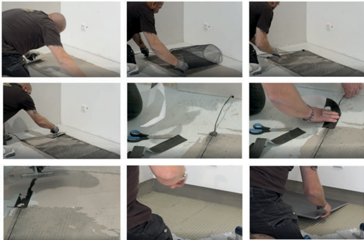
Abbildung 8: Fliesenkleber auftragen (6 mm Zahnung), thermoheld •FLIESE• Heizgitter ausrichten und abrollen, glatt gestrichen. Spannungszuleitungen am mit beigefügtem Klebeband Boden befestigen. Erneuter Auftrag von Fliesenkleber (Zahnung entsprechend der Fliesen wählen) und Auflegen der Fliesen. Im Randbereich ohne Gitter gröbere Zahnung verwenden (ca. 2 – 4 mm größer).
