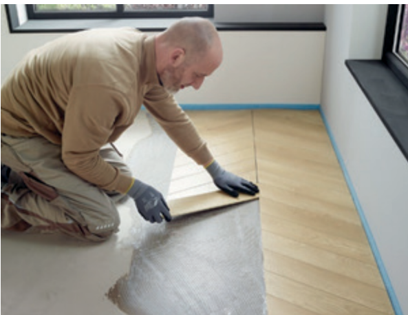
Abbildung 19: Parkettkleber auftragen und Parkett verlegen
