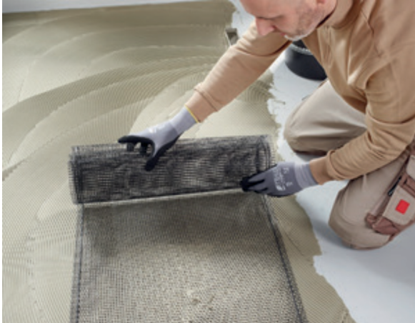
Abbildung 10: thermoheld •FLIESE• Heizgitter einlegen und abrollen, glattstreichen. Befestigung der Zuleitungen mit Klebeband. Im Randbereich ohne Gitter gröbere Zahnung verwenden (ca. 2 – 4 mm gröber).
