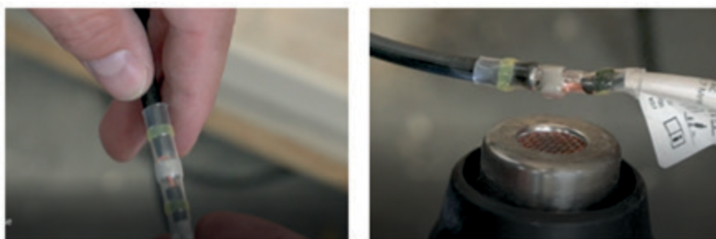
Abbildung 24: Verlängern der Zuleitungen mithilfe der beigegeführten Lötverbinder
