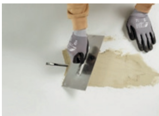
Abbildung 7: Einbetten des Bodenfühlers ohne (links) oder mit Leerrohr (rechts) in Spachtelmasse
