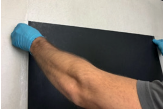
Abbildung 5: Anlegen der thermoheld •FLEX• Heizfläche an Markierung, schwarze Seite nach vorne
