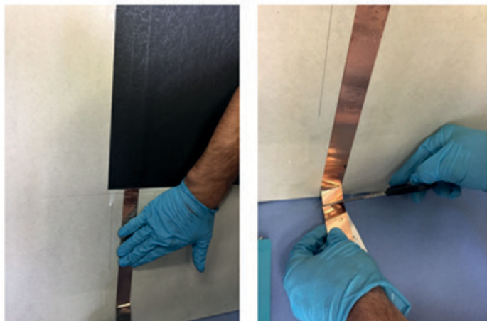
Abbildung 7: Elektrodenbänder ankleben (links) und mit 1 cm Überlänge abschneiden (rechts)
