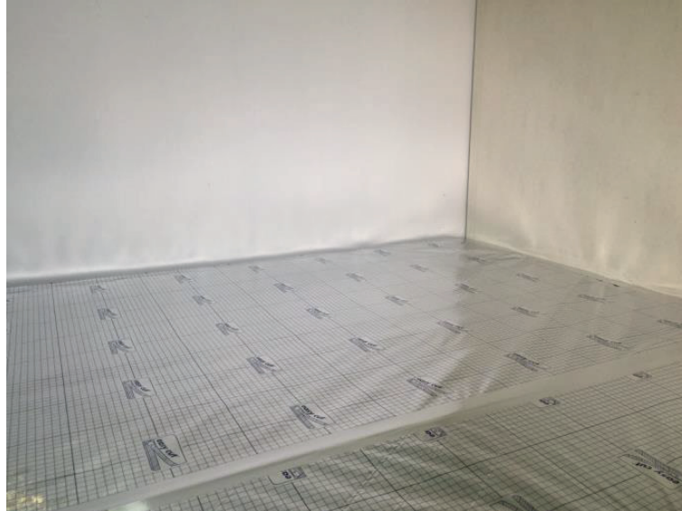
Abbildung 11: Einbringen der Wasserdampfdiffusionssperre und Abdichten mit Alu-Band
