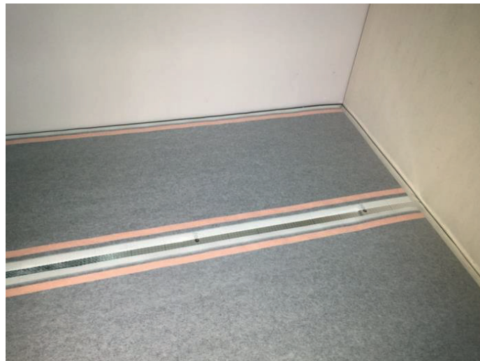
Abbildung 6: Verlegen der thermoheld •BODEN• Heizbahnen
