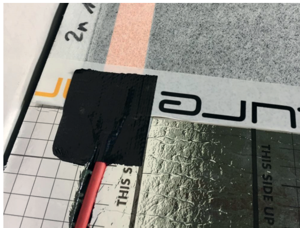
Abbildung 9: Kabel in die vorgesehenen Schlitzte in der Dämmung einlegen. Schlitzte mit Alu-Band wieder verschließen.
