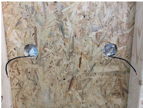
Abbildung 5: Hintere Planke mit Löchern für die Kabeldurchführungen
