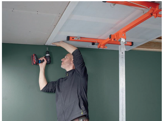
Abbildung 3: Montage der thermoheld •WAND• an der Decke mit Plattenheber
