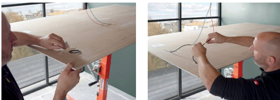
Abbildung 8: Verkabelung der thermoheld •WAND• Heizplatte: Aufkleber über den nötigen Anschlusskabeln entfernen und mit Wago-Klemme Anschlusskabel und Zuleitungen der 24 V Spannungsversorgung verbinden.
