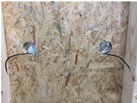
Abbildung 5: Hintere Planke mit Löchern für die Kabeldurchführungen
