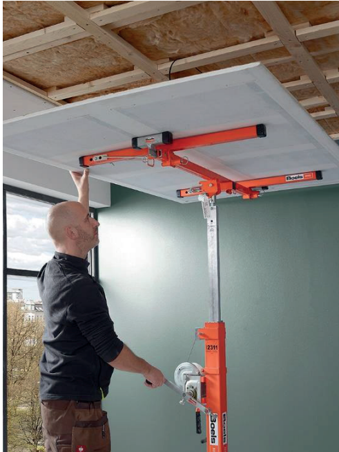
Abbildung 3: Montage der thermoheld •WAND• an der Decke mit Plattenheber
