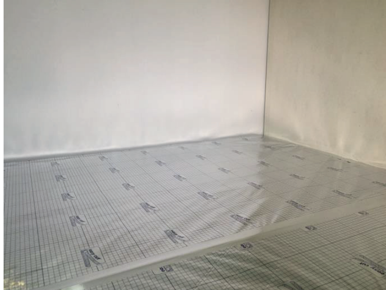
Abbildung 11: Einbringen der Wasserdampfdiffusionssperre und Abdichten mit Alu-Band
