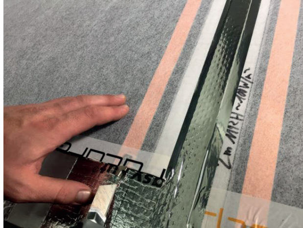
Abbildung 8: Schmale Schlitzte werden für die Kabelführung in die Dämmung geschnitten
