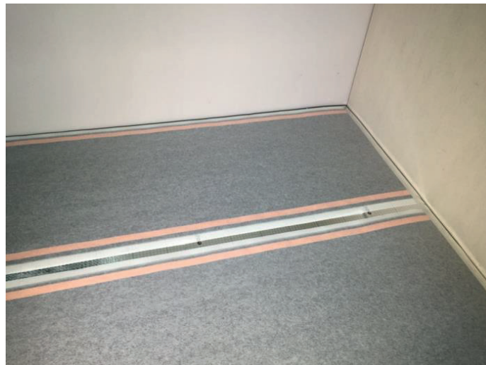
Abbildung 6: Verlegen der thermoheld •BODEN• Heizbahnen
