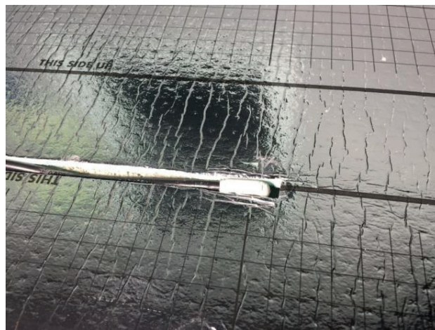
Abbildung 4: Einlegen des Bodensensors
