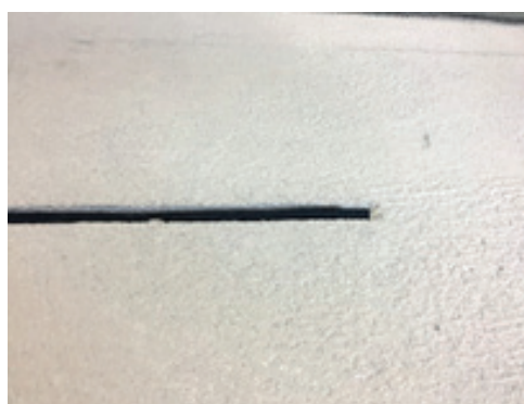
Abbildung 7: Einbetten des Bodenfühlers ohne (links) oder mit Leerrohr (rechts) in Spachtelmasse
