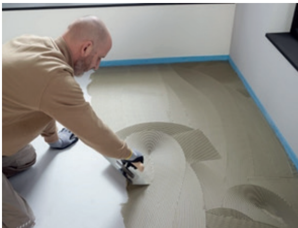
Abbildung 15: Kleber auftragen (4 - 6 mm Zahnung)
