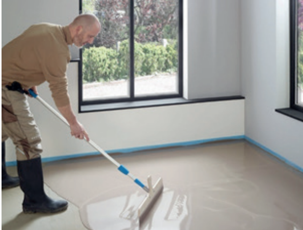
Abbildung 18: Dünn nivellieren und entlüften
