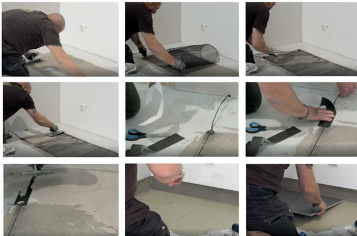
Abbildung 8: Fliesenkleber auftragen (6 mm Zahnung), thermoheld •FLIESE• Heizgitter ausrichten und abrollen, glatt gestrichen. Spannungszuleitungen am mit beigefügtem Klebeband Boden befestigen. Erneuter Auftrag von Fliesenkleber (Zahnung entsprechend der Fliesen wählen) und Auflegen der Fliesen. Im Randbereich ohne Gitter größere Zahnung verwenden (ca. 2 – 4 mm größer).
