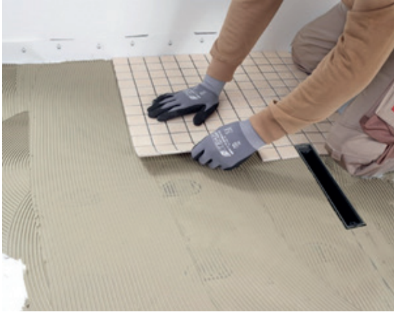
Abbildung 13: Fliesenkleber auftragen und Fliesen legen.
