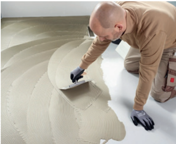
Abbildung 9: Fliesenkleber auftragen (6 mm Zahnung).
