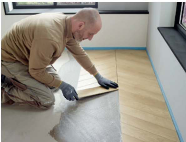
Abbildung 19: Parkettkleber auftragen und Parkett verlegen
