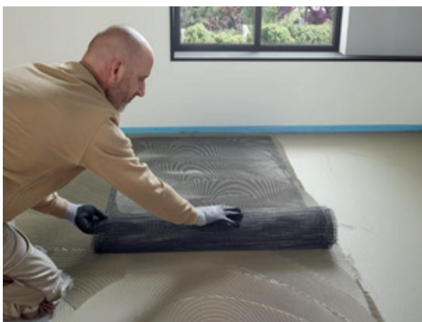
Abbildung 16: thermoheld •FLIESE• einlegen
