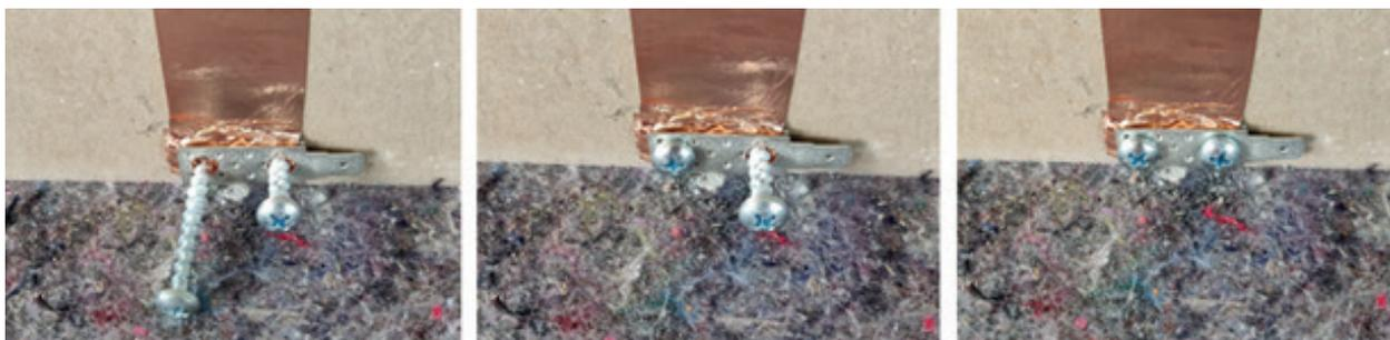
**Abbildung 10: Eindrehen der Schrauben zur Befestigung der Crimps an der Wand**
