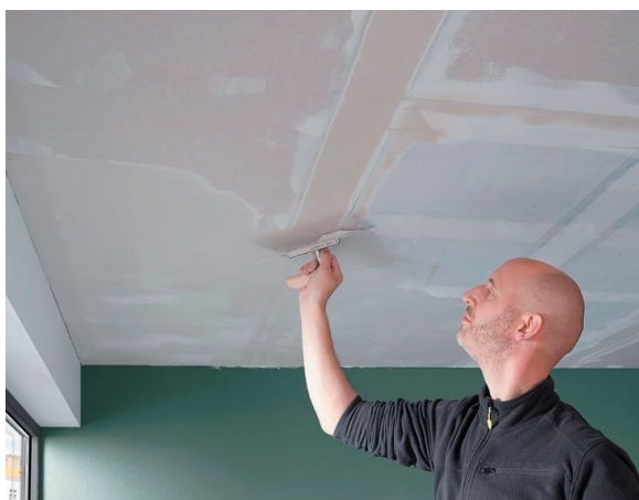
Abbildung 10: Verspachteln der Stöße, Verschraubungen und Heizflächen. Vorsicht bei Heizflächen und Elektroden! Parallel zu Elektroden arbeiten, kein scharfes Werkzeug verwenden!
