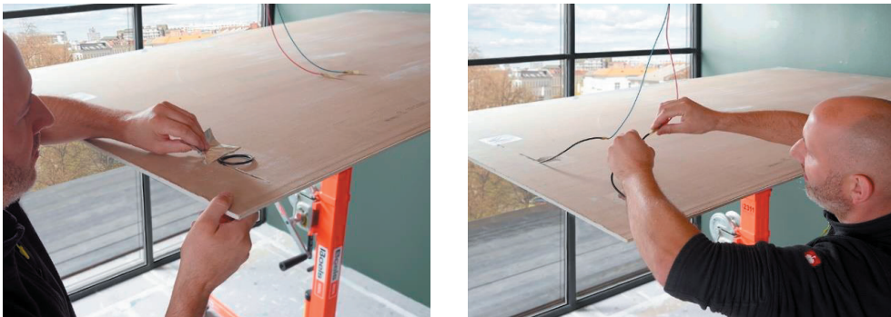
Abbildung 8: Verkabelung der thermoheld •WAND• Heizplatte: Aufkleber über den nötigen Anschlusskabeln entfernen und mit Schrumpf-Stoß-Crimp-Verbinder Anschlusskabel und Zuleitungen der 24 V Spannungsversorgung vercrimpen.
