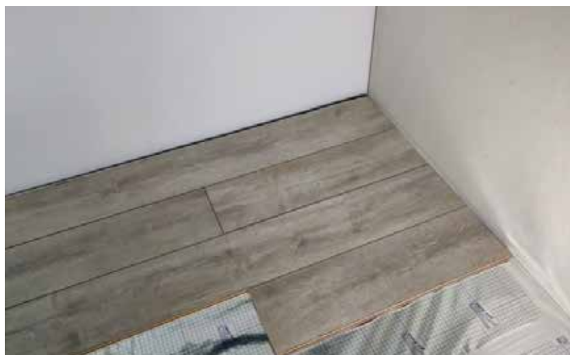
Abbildung 12: Verlegen des Bodenbelags hier am Beispiel Laminatboden
