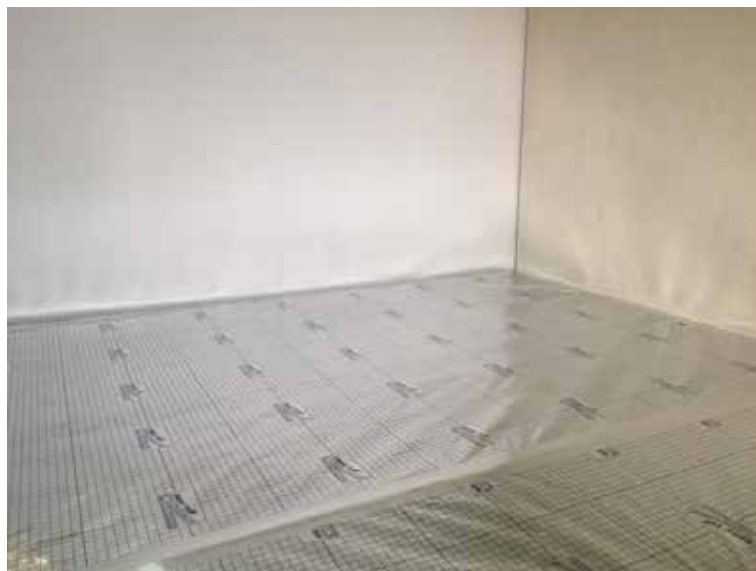
Abbildung 11: Einbringen der Wasserdampfdiffusionssperre und Abdichten mit Alu-Band
