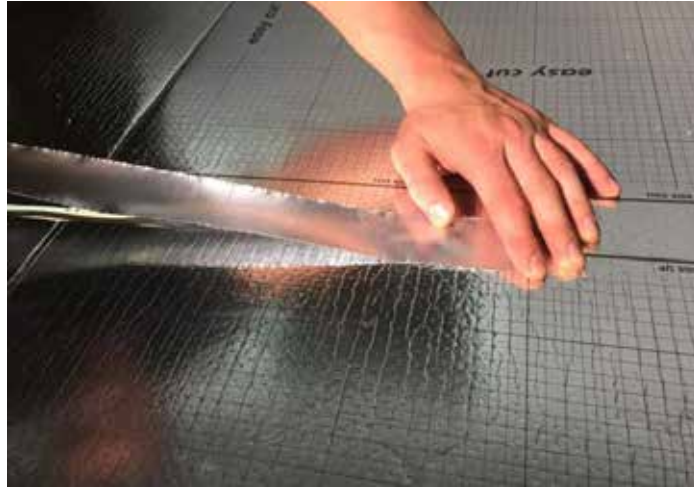
Abbildung 5: Abdichten der Schlitzte und Stoßfugen mit Alu-Dichtband
