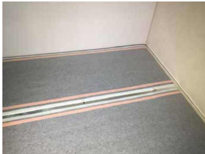
Abbildung 6: Verlegen der thermoheld •BODEN• Heizbahnen
