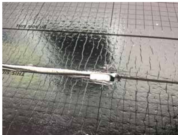
Abbildung 4: Einlegen des Bodensensors
