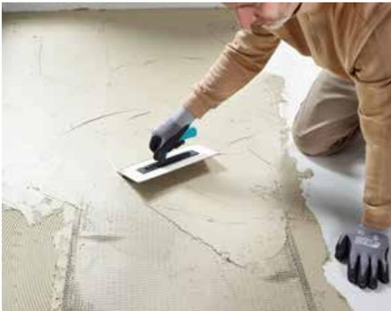
**Abbildung 11: Weitere Lage Dichtbahnkleber auftragen (Hinweise zur Klebung der Dichtbahn des jeweiligen Dichtbahnherstellers beachten).**
