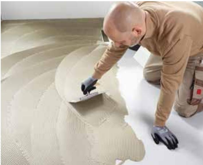
**Abbildung 9: Fliesenkleber auftragen (6 mm Zahnung).**
