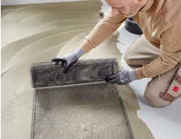
**Abbildung 10: thermoheld •FLIESE• Heizgitter einlegen und abrollen, glattstreichen. Befestigung der Zuleitungen mit Klebeband. Im Randbereich ohne Gitter gröbere Zahnung verwenden (ca. 2 – 4 mm größer).**
