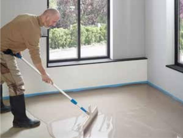
**Abbildung 18: Dünn nivellieren und entlüften**
