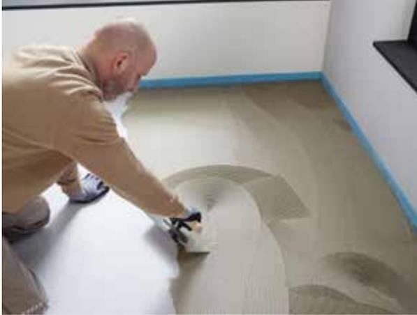
**Abbildung 15: Kleber auftragen (4 - 6 mm Zahnung)**
