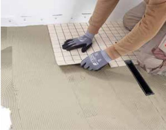
**Abbildung 13: Fliesenkleber auftragen und Fliesen legen.**
