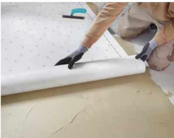
**Abbildung 12: Dichtbahn direkt in den noch feuchten Dichtbahnkleber legen.**
