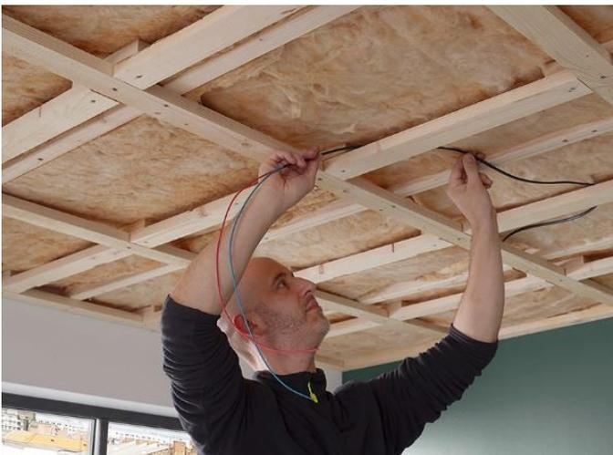
**Abbildung 2: Beispiel einer Decken-Unterkonstruktion aus Holz. Die Kabel müssen hier vor Montage der thermoheld •WAND• verlegt werden.**
