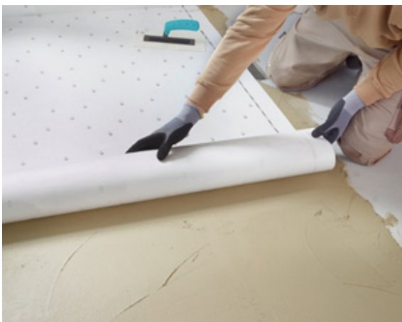
Abbildung 12: Abdichtbahn direkt auf die noch feuchte Abdichtmasse legen.
