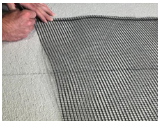
Abbildung 6: Anzeichnen der Lage für die thermoheld •FLIESE• und den Bodenfühler
