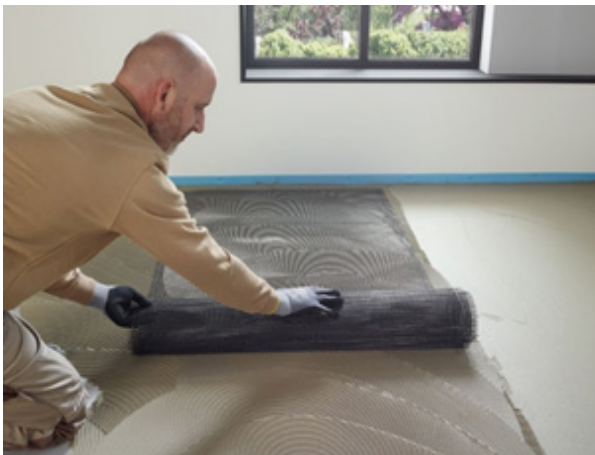
Abbildung 16: thermoheld •FLIESE• einlegen
