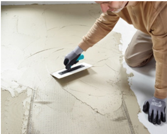
Abbildung 11: Weitere Lage Abdichtmasse wird aufgetragen (mit Zahnkelle, 4 mm Zahnung) und direkt darüber Abdichtbahn legen.
