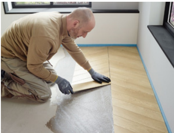
Abbildung 19: Parkettkleber auftragen und Parkett verlegen
