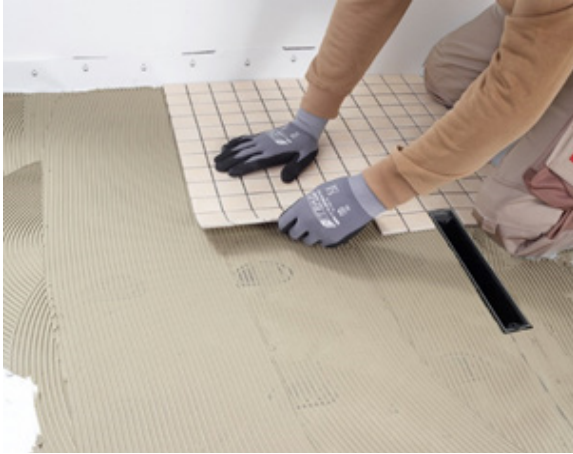
Abbildung 13: Fliesenkleber auftragen und Fliesen legen.
