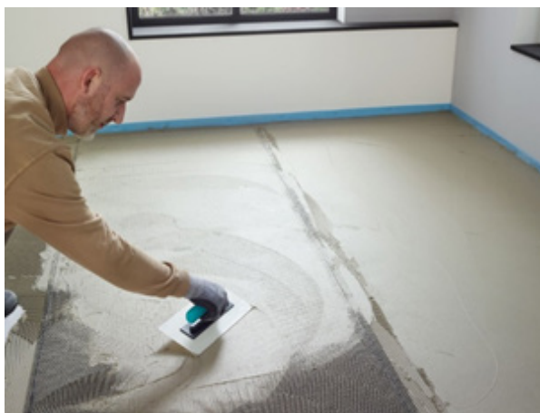
Abbildung 17: Glattstreichen. Im Randbereich ohne Gitter höhere Zahnung verwenden (z. B. 5 – 6 mm).
