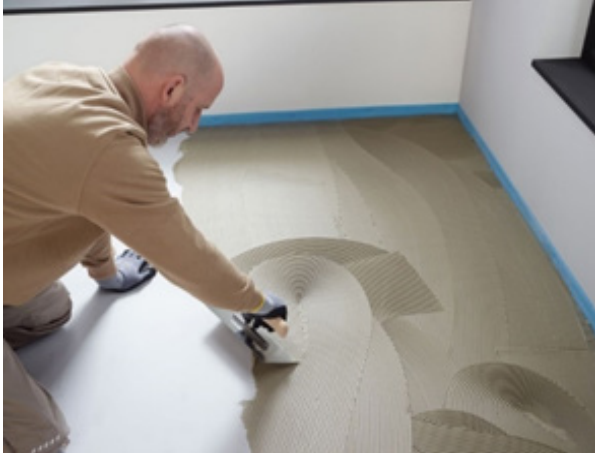
Abbildung 15: Kleber auftragen (4 mm Zahnung)
