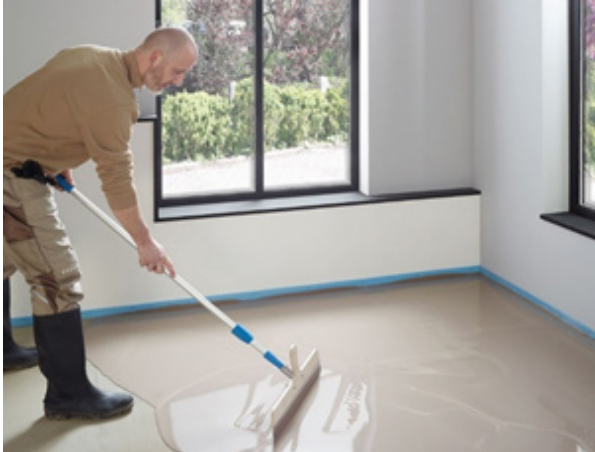
Abbildung 18: Dünn nivellieren und entlüften
