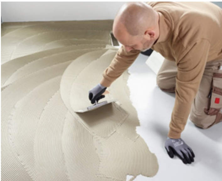
Abbildung 9: Fliesenkleber auftragen (6 mm Zahnung).
