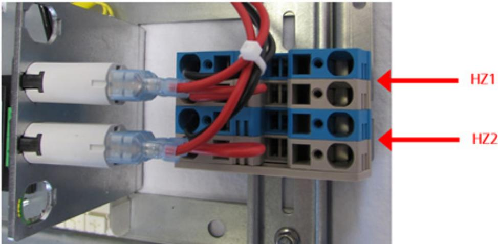
Abbildung 3: Anschluss für die Heizonen HZ1 bis HZ2 der Spannungsversorgung CeT Power 700 UP
